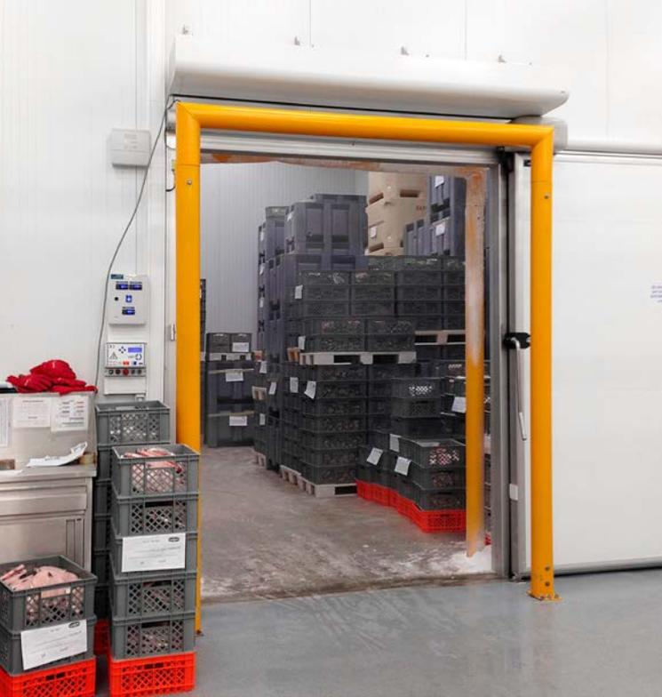
Des tests réalisés indépendamment montrent qu'un rideau d'air installé correctement peut réduire de près de 80 % les pertes d'énergie liées à une porte ouverte. Un rideau d'air correctement installé couvre la largeur et la hauteur d'une ouverture et est adapté aux contraintes auxquelles il est exposé.
