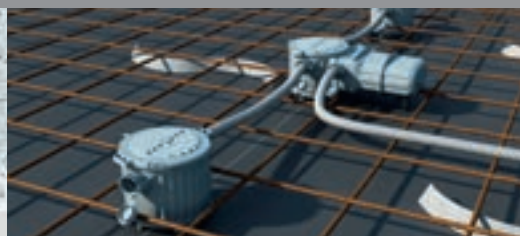
Pas de découpe supplémentaire de l'armature au niveau du tunnel
